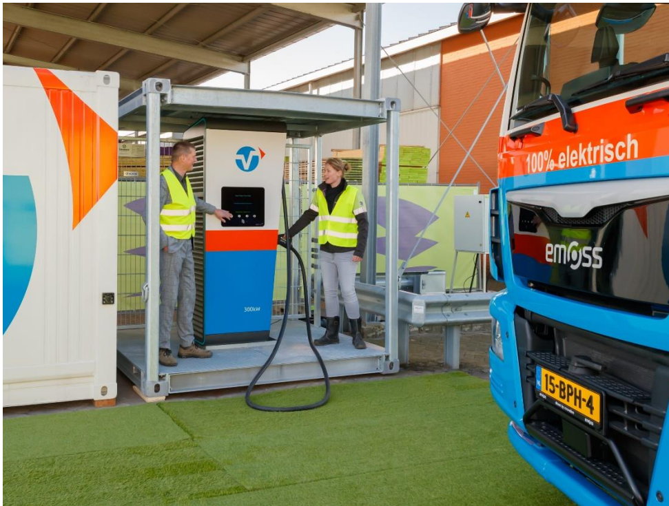
Figuur 2: Mobiel snellaadpunt dat wordt gebruikt in het DKTI VERZET-project. Bron foto: Vlot Logistics.
